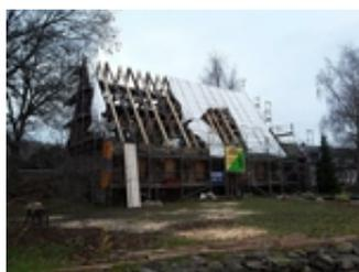
Im Juni 2016 startete das Bauvorhaben „Sanierung der Kirche Triglitz“ mit dem Einrüsten der Kirche innen und außen. Anschließend wurde die Dacheindeckung zurück gebaut, um das Dachtragwerk sanieren zu können. Weiterhin erfolgte in den ersten Wochen eine umfangreiche restauratorische Begutachtung der Kirche. Anschließend wurde auch die marode Deckendielung zurück gebaut.
