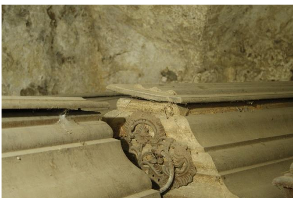
Abb. 15, Sarg 7, Griffbeschlag und beschädigte Deckelplatte
