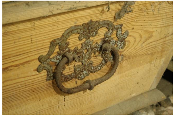
Abb. 20. Sarg 9, Beschlag mit Resten der Verzinnung
