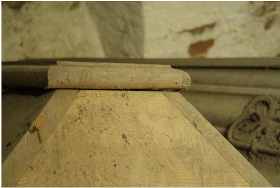
Abb. 21. Sarg 9, partielle Ablösung der Deckelplatte
