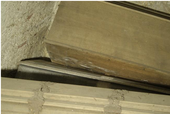
Abb. 11, Sarg 4, Schimmelbefall an der Unterseite
